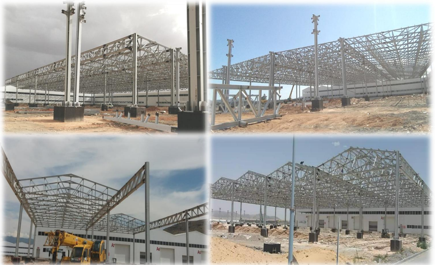
Montage de l'extension de l'usine d'assemblage des véhicules pour le compte du groupe GLOVIZ sur environ 40 000 m 2 à Djerma, Batna
